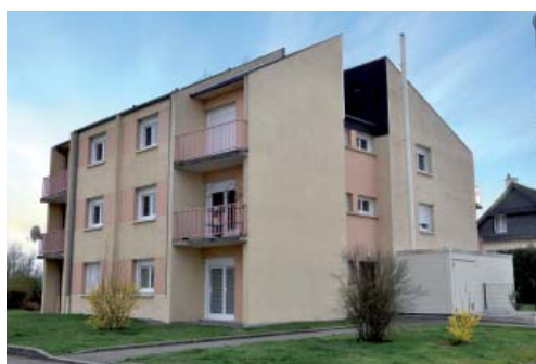
Logements sociaux chauffés par une ENERGY BOX
