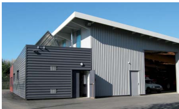
Ateliers Municipaux chauffés par une PELLEMATIC et des capteurs solaires PELLESOL
